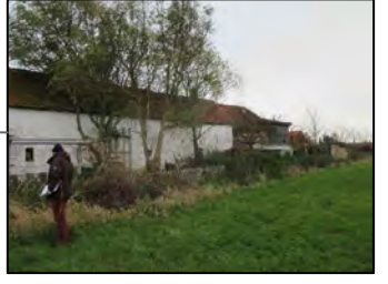
Blickrichtung nach Osten (Richtung Gebäude/Herzstraße)
